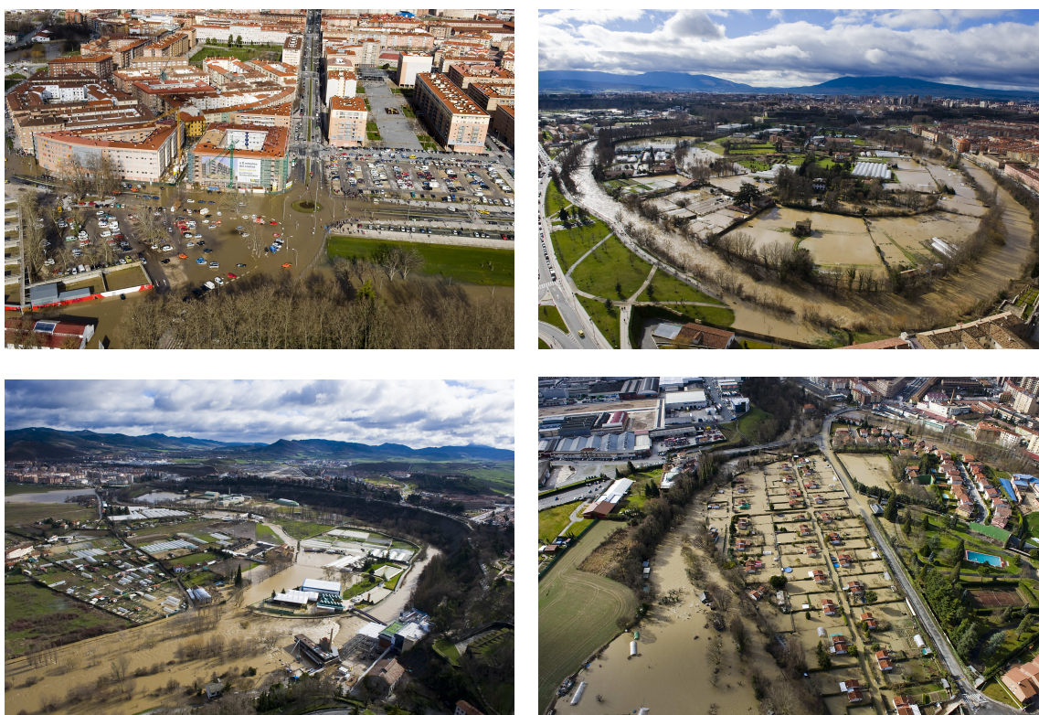
Figura 1.- Fotos de las inundaciones del 12 de febrero de 2009 en Pamplona.
